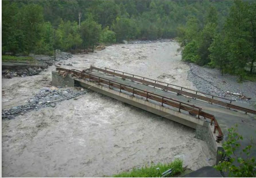
**Figure 8.** *Progetto definitivo - Adeguamento del ponte in loc. La Fucina a seguito dell'evento alluvionale - Anno 2010.*
