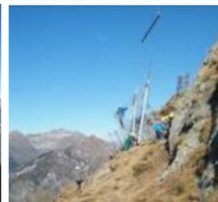
Fasi operative: perforazioni delle fondazioni, elitransporto e montaggio delle strutture
