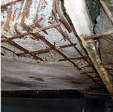
In presenza di condizioni ambientali particolari (umidità, temperatura, cicli gelo-disgelo, sostanze chimiche...) si possono creare importanti fenomeni di corrosione delle armature. Attraverso la misura del potenziale elettrochimico delle barre di armatura sotto traccia è possibile valutare lo stato di corrosione o il potenziale processo evolutivo.
