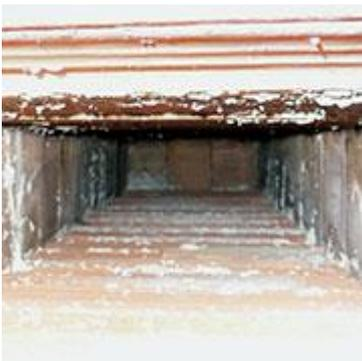
Mediante l’esecuzione di microfori (diametro 10 mm) è possibile introdurre apposita sonda a fibra ottica e registrare le immagini della stratigrafia di elementi architettonici e strutturali.
